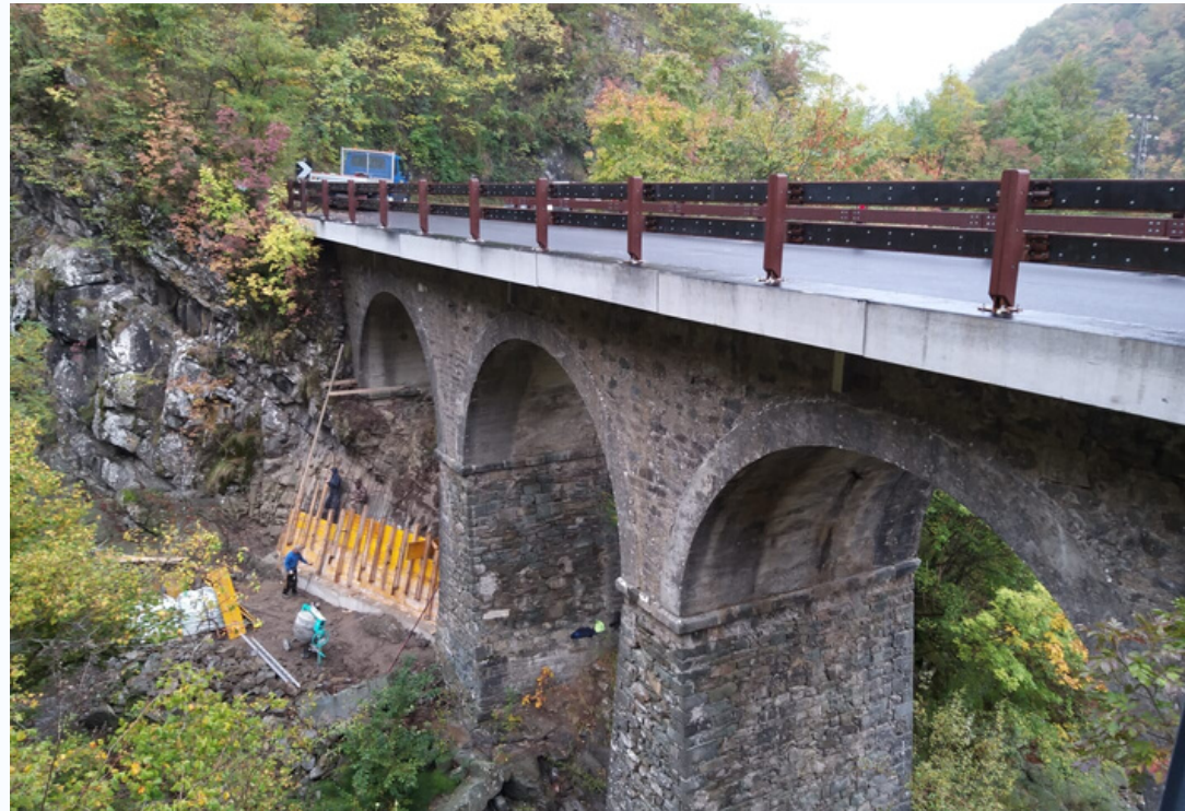
PONTE SUL RIO SCABBIE
